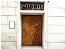
Sanierte Bestandstür am Augsburger Rathaus
