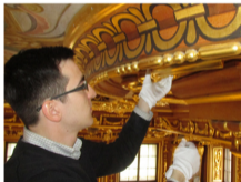
Begutachtung der Decke des Goldenen Saales im Augsburger Rathaus
