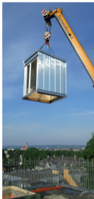
Montage eines Treppenaufgangs
